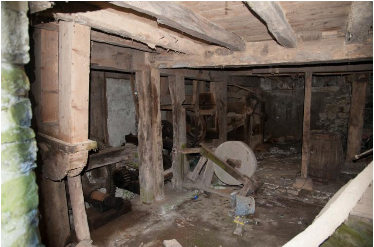
Vue intérieure de l'étage de soubassement.
