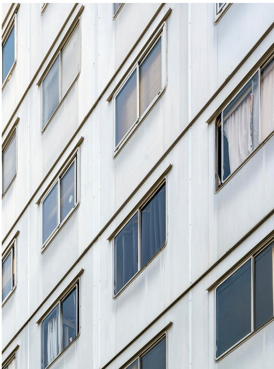
Façade nord de l'immeuble des Cèdres
