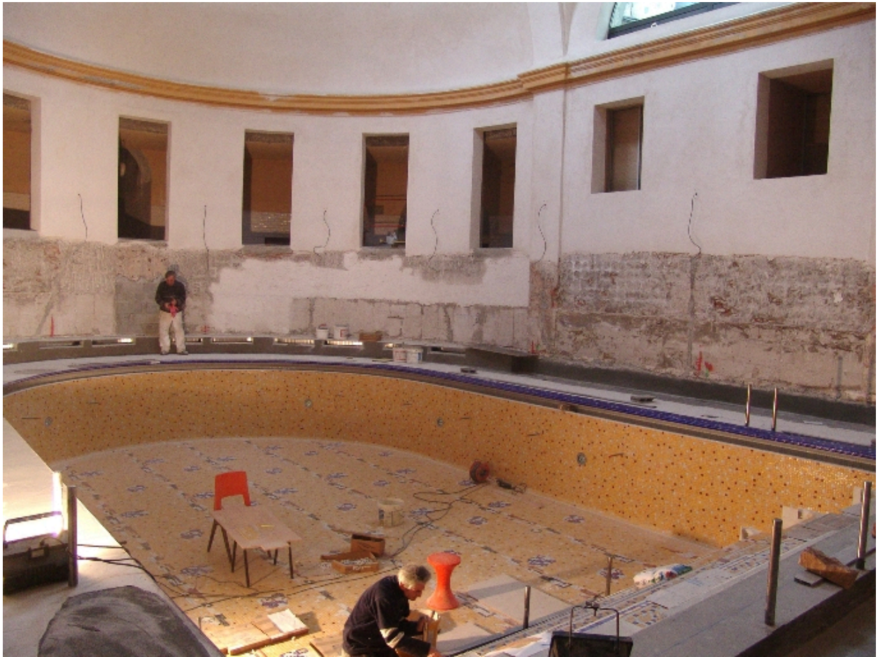
Piscine en cours de restauration
