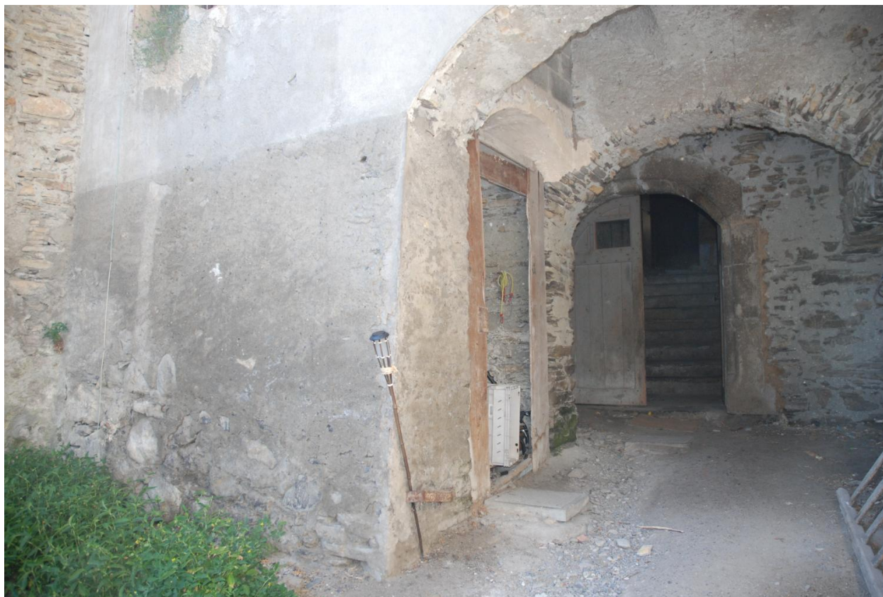
Vue depuis la cour au sud-ouest : massif de soutènement de l'escalier et porte de la cave.
