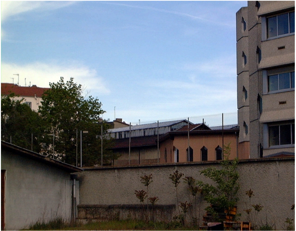
Vue nord-ouest des sheds des ateliers devenus le gymnase de l'école privée Charles de Foucauld
