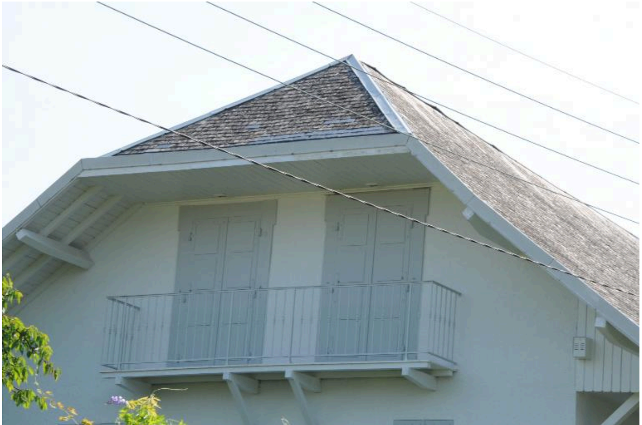
Détail du pignon ouest
