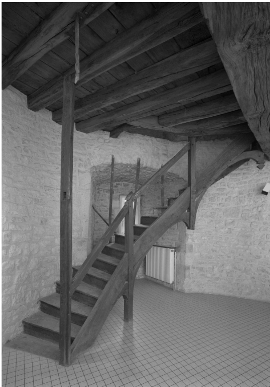
Escalier suspendu au 2ème étage de la tour d'angle sud-ouest.
