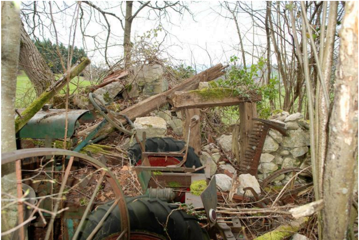
Vue d'ensemble du four à pain en ruine.
