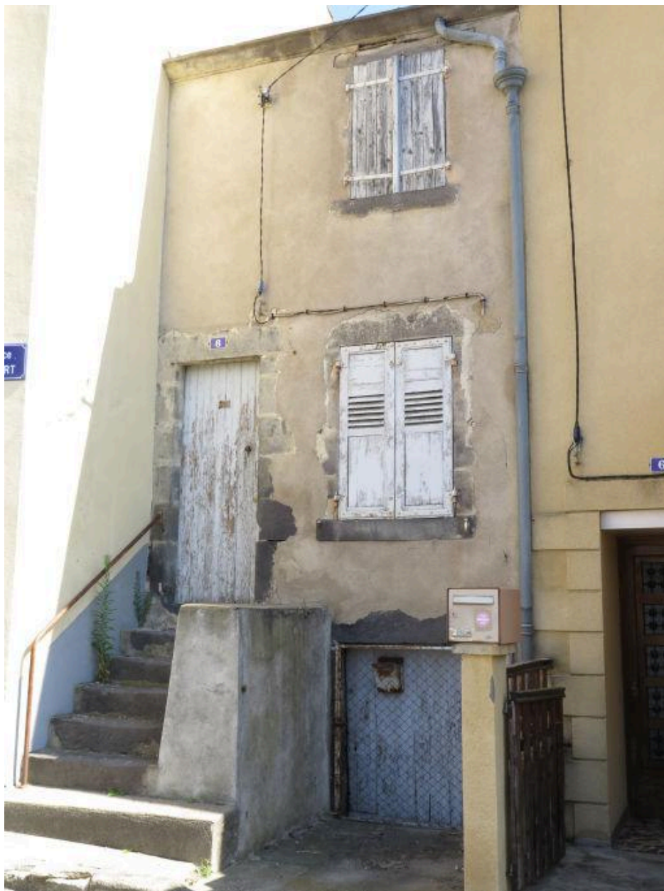
Escalier rez-de-chaussée surélevé : Aulnat, 8 rue de la Tour
