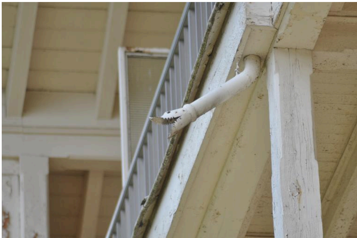
Détail d'une gouttière
