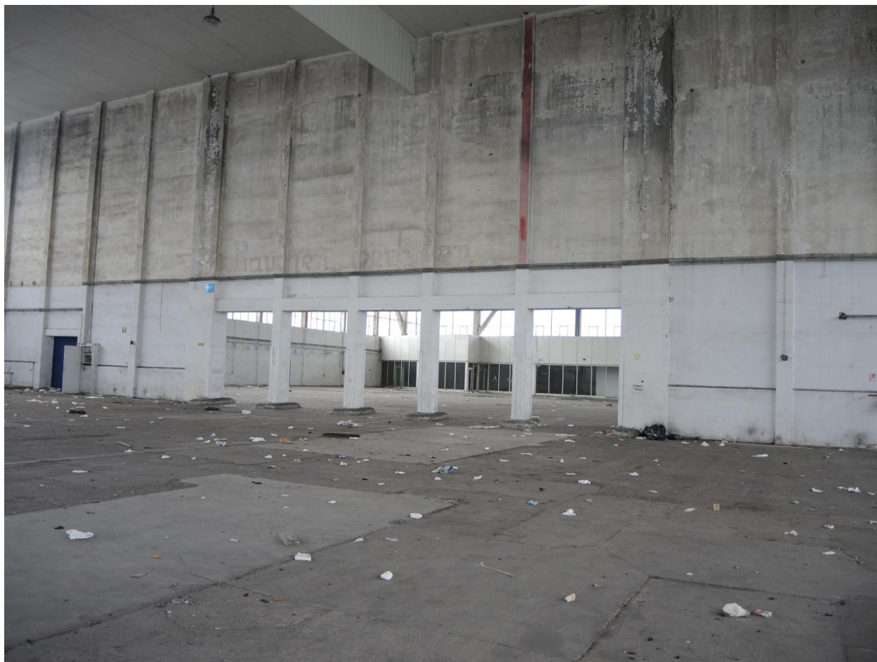
Hangar VI photo vue d'intérieur
