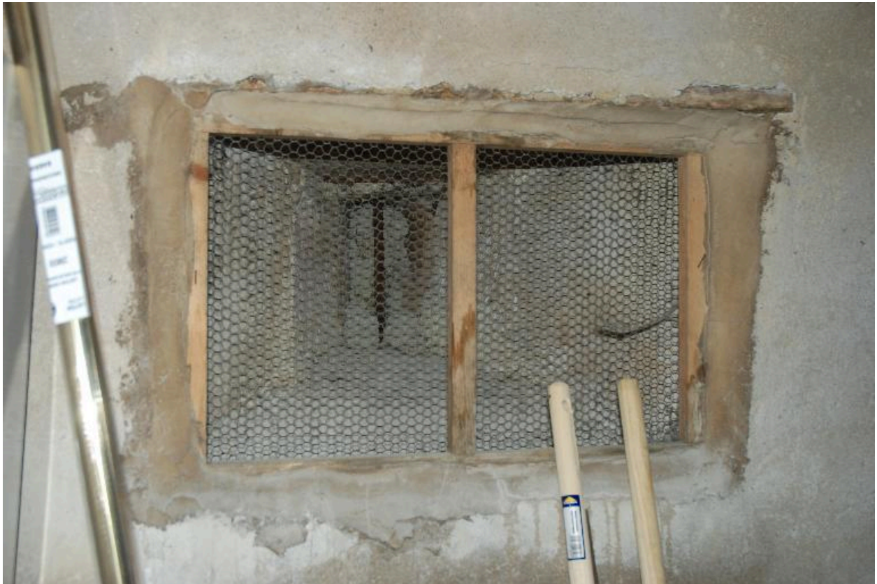
Rez-de-chaussée. Intérieur de la cave 2, ancien jour muré situé dans le mur sud.
