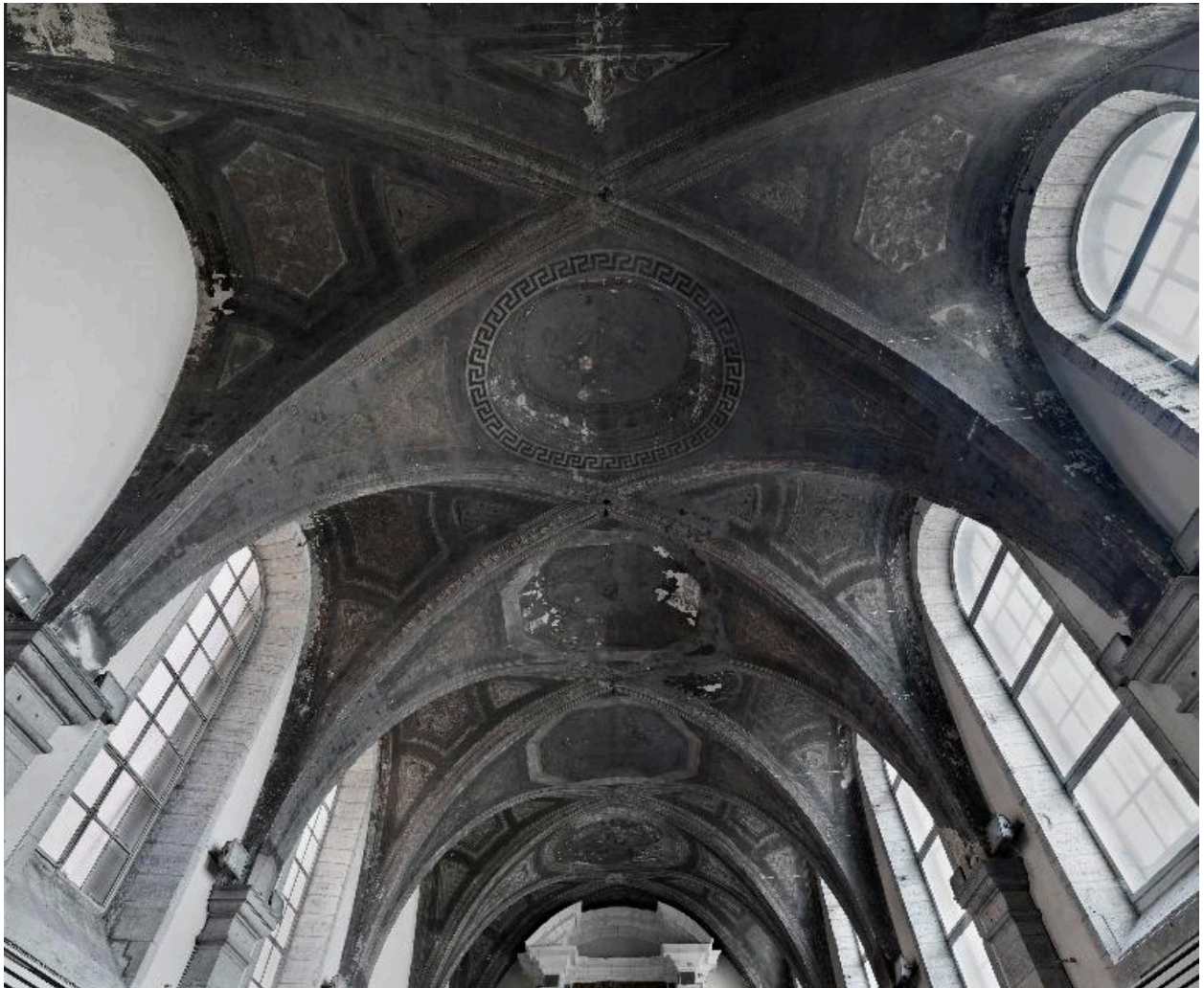
Vue d'ensemble de la voûte depuis la nef
