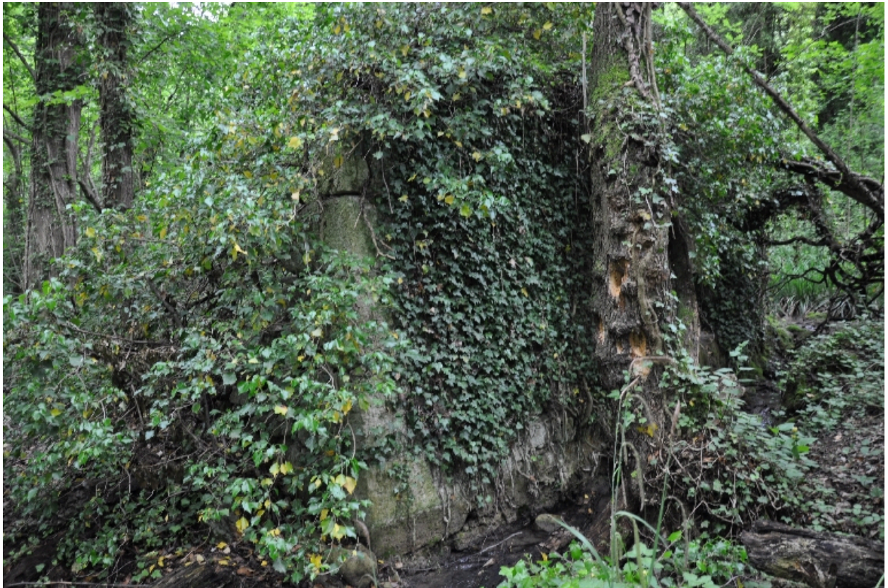
Vue de la façade ouest du moulin aval, ancien emplacement de la roue
