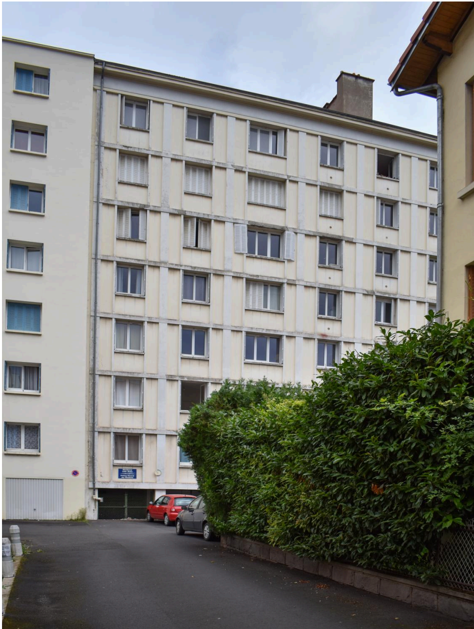
Elévation postérieure vue depuis le coeur d'îlot
