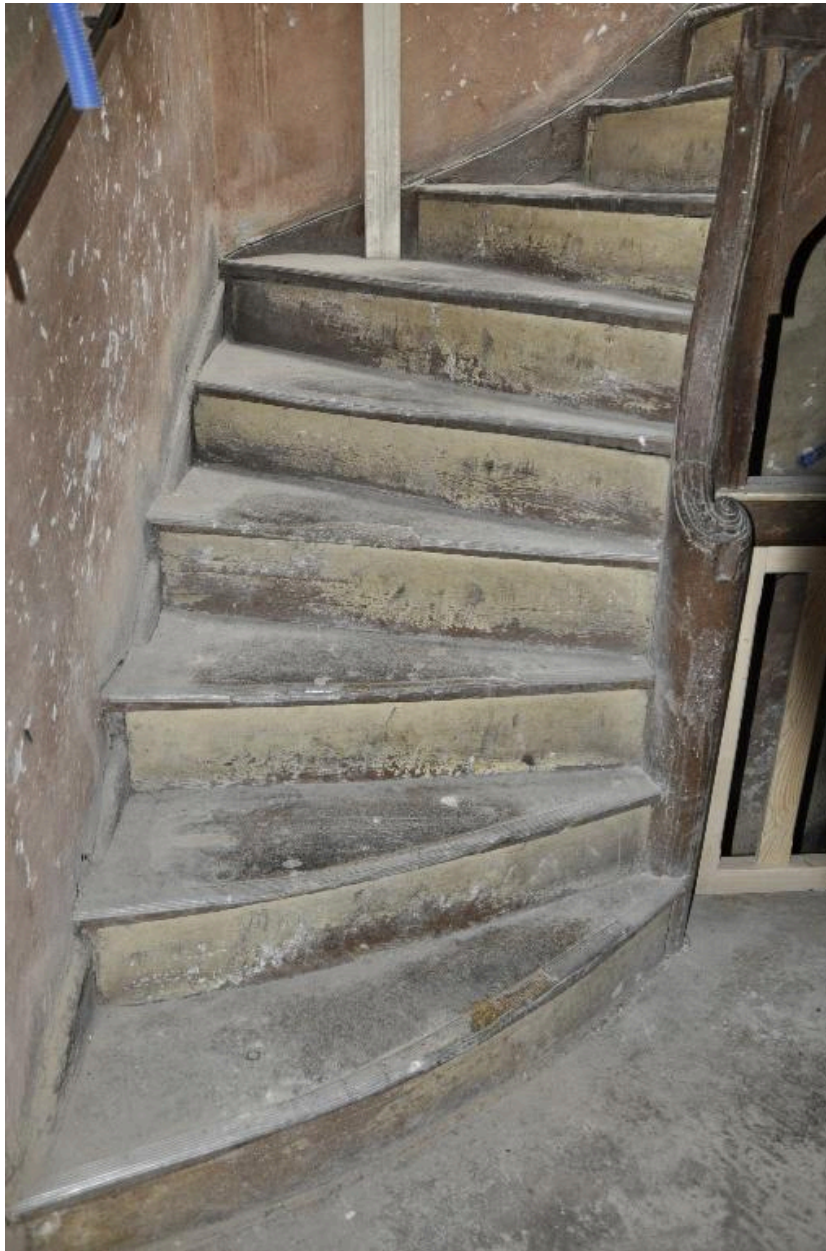
Vue de la seconde volée de l'escalier
