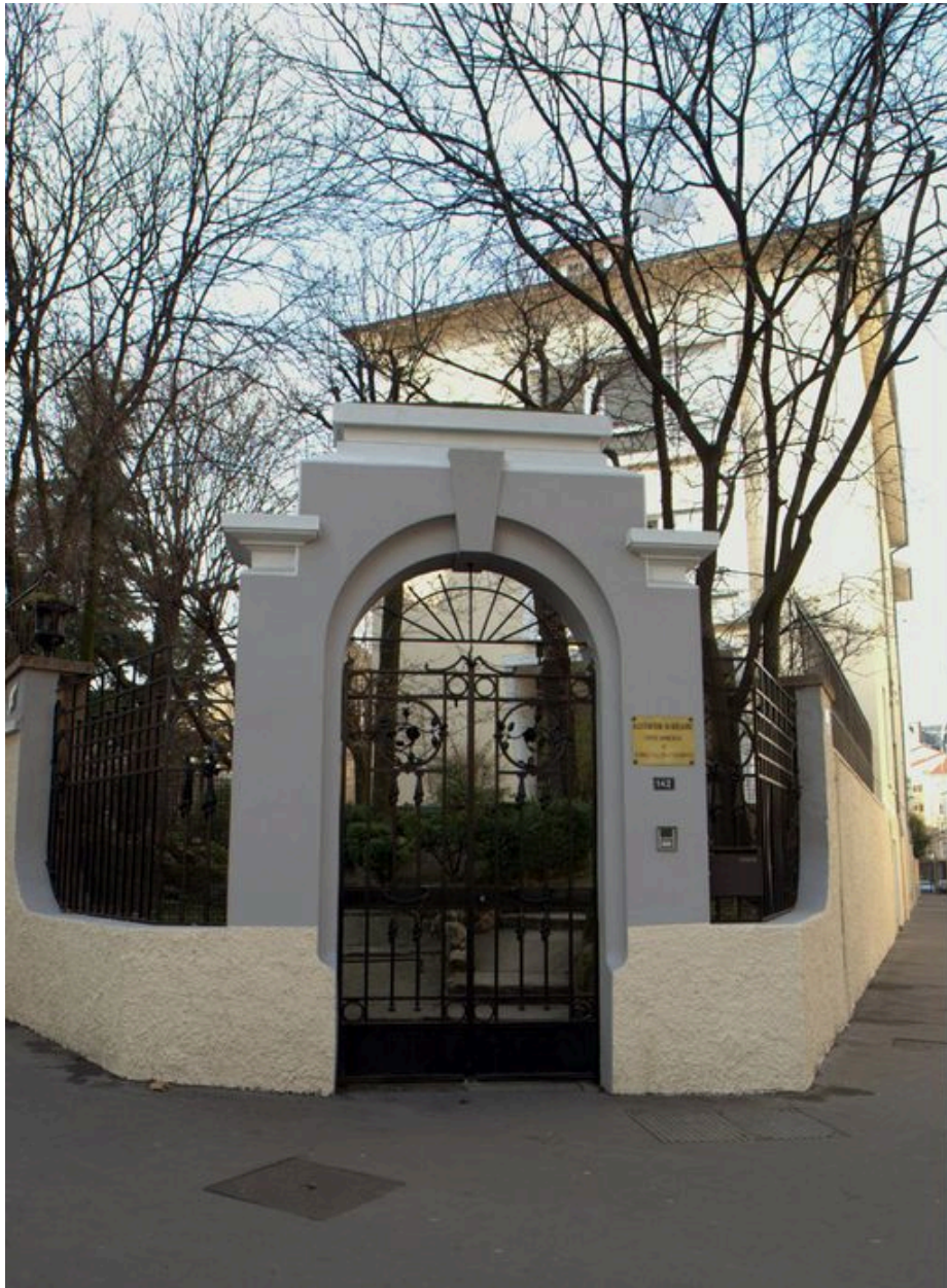
Porte principale, vue depuis la rue
