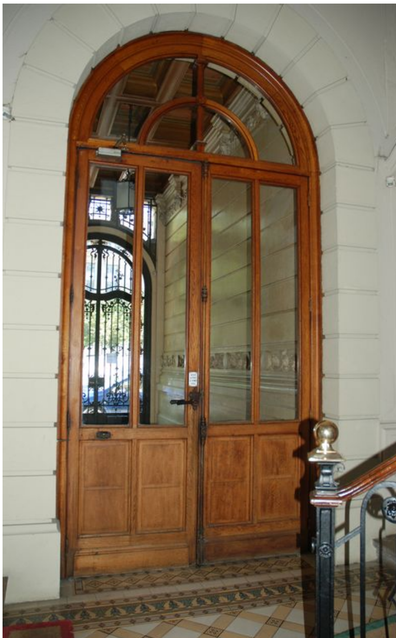
La porte du sas, vue depuis la cage d'escalier
