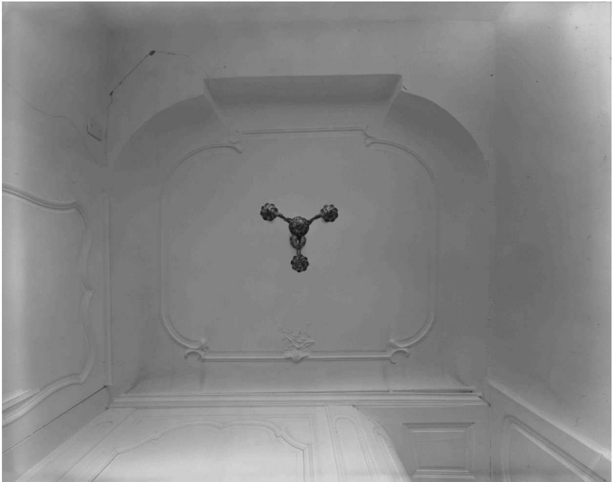
Vue d'ensemble du plafond d'un petit cabinet du rez-de-chaussée.
