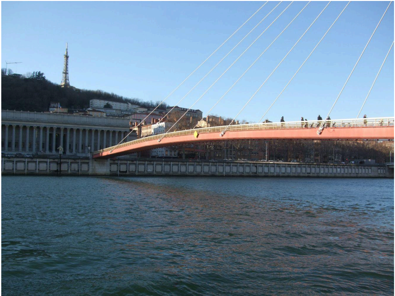
Vue sud-est de la tour
