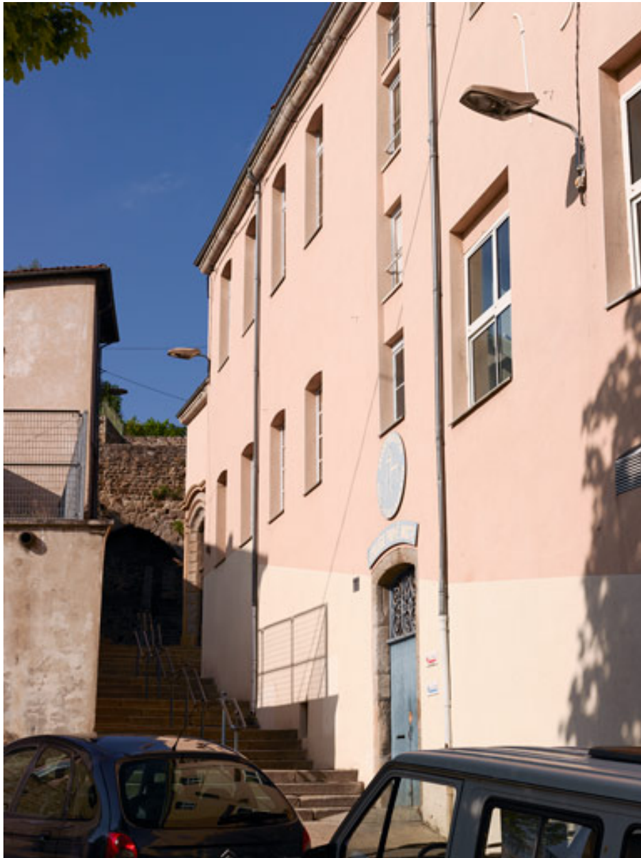
Vue partielle de l'élévation sur la rue du Collège.
