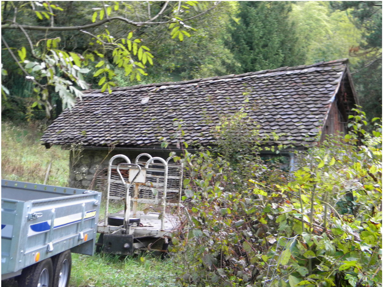
Vue de la façade ouest
