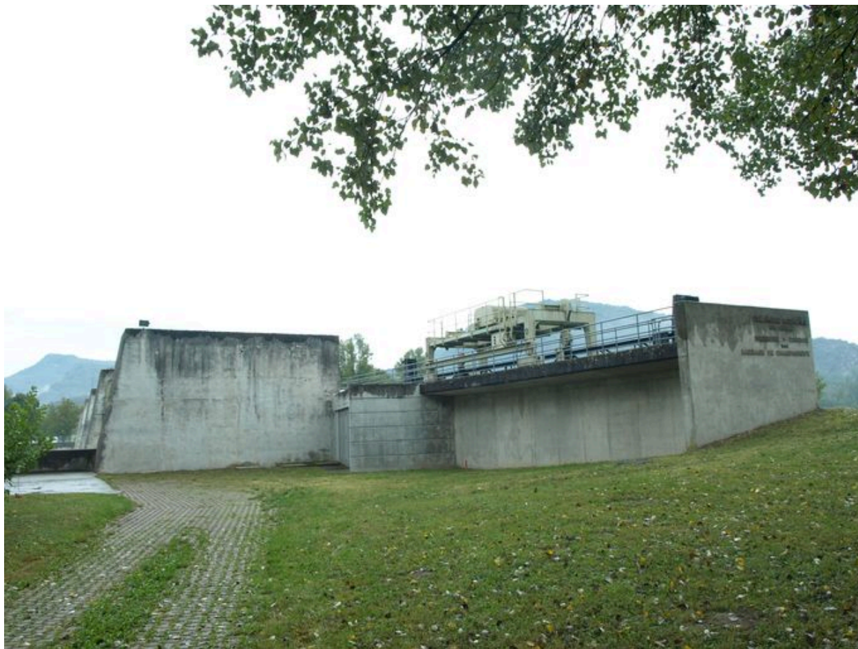
Barrage et palan, face aval (depuis la rive gauche)
