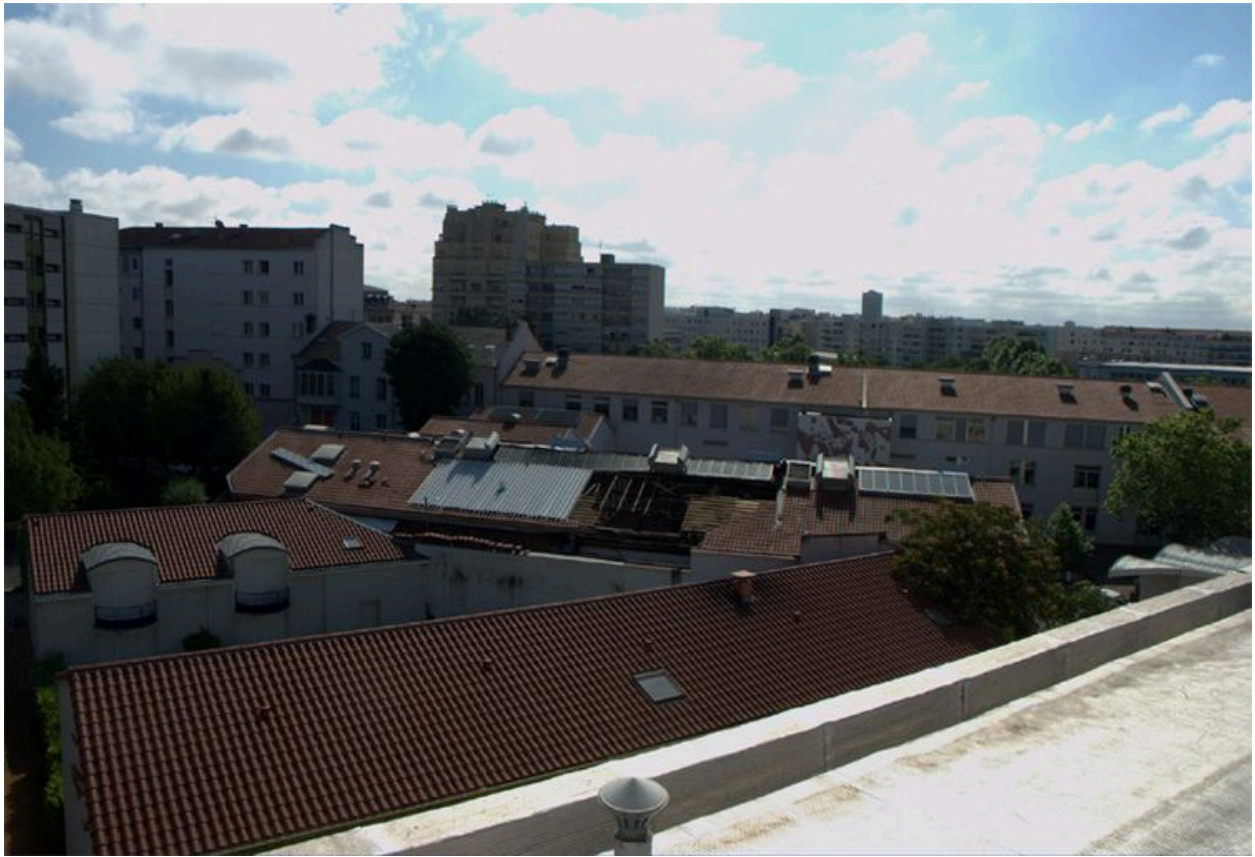
Vue des bâtiments depuis l'ouest
