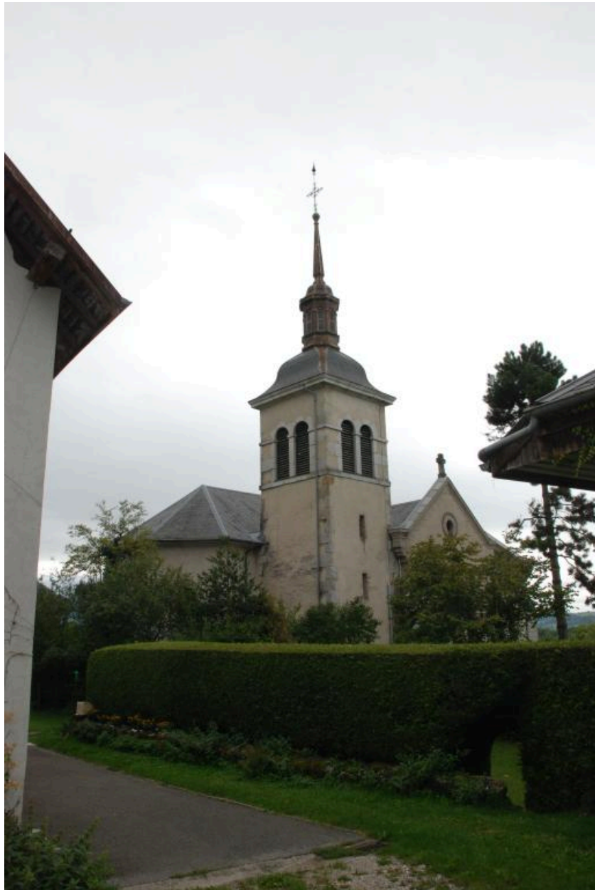
Vue d'ensemble de la façade nord de l'église.
