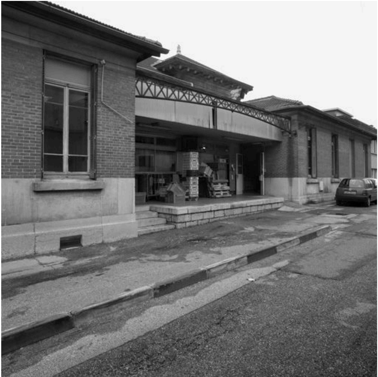
Bâtiment B, façade postérieure, pavillons carrés et quai de déchargement
