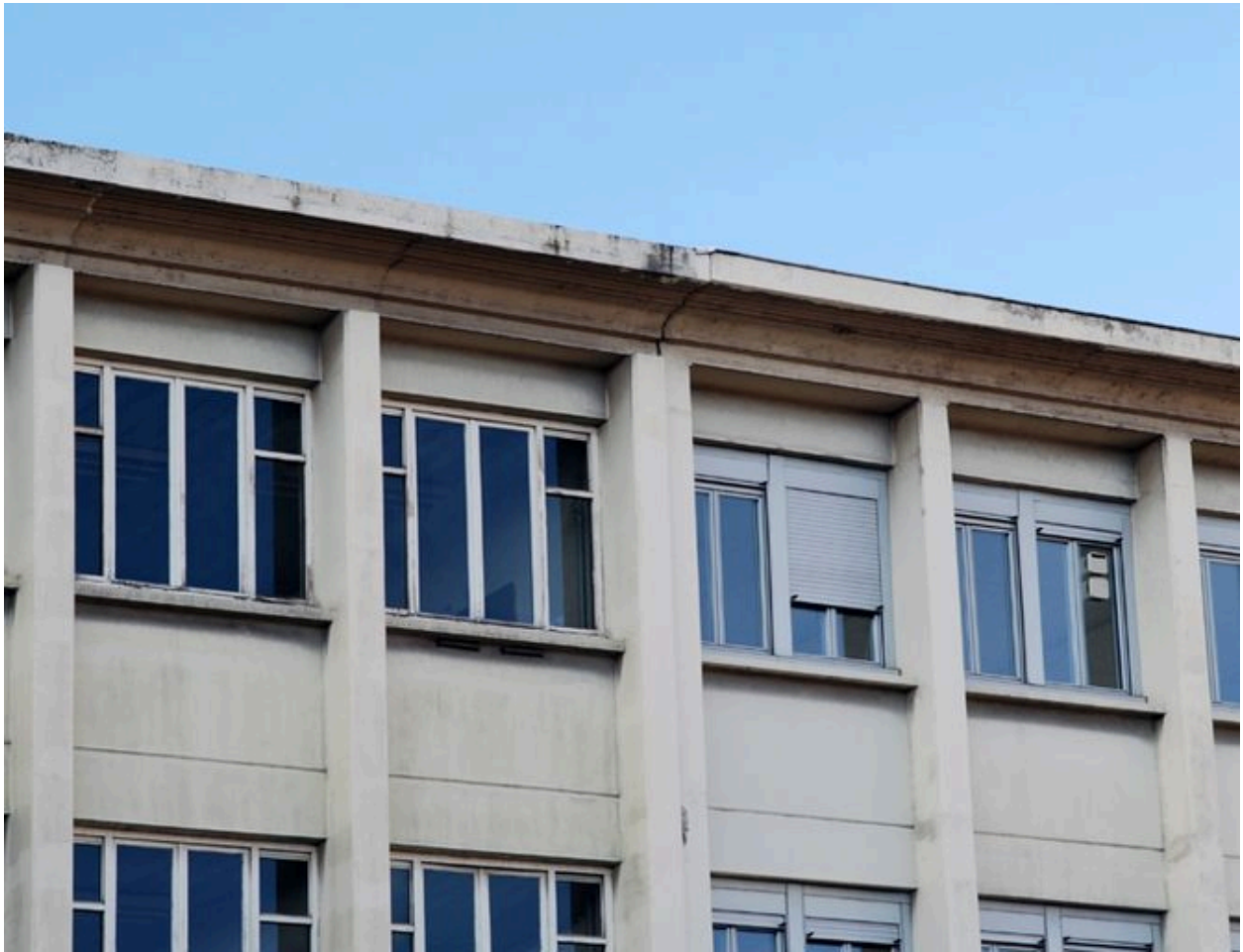
Bâtiment ISARA, élévation antérieure, détail de la corniche avec séparation entre les deux tranches de construction
