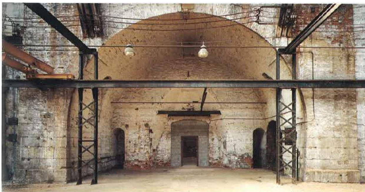
Usine d'appareils de pesage Béranger-Trayvou
