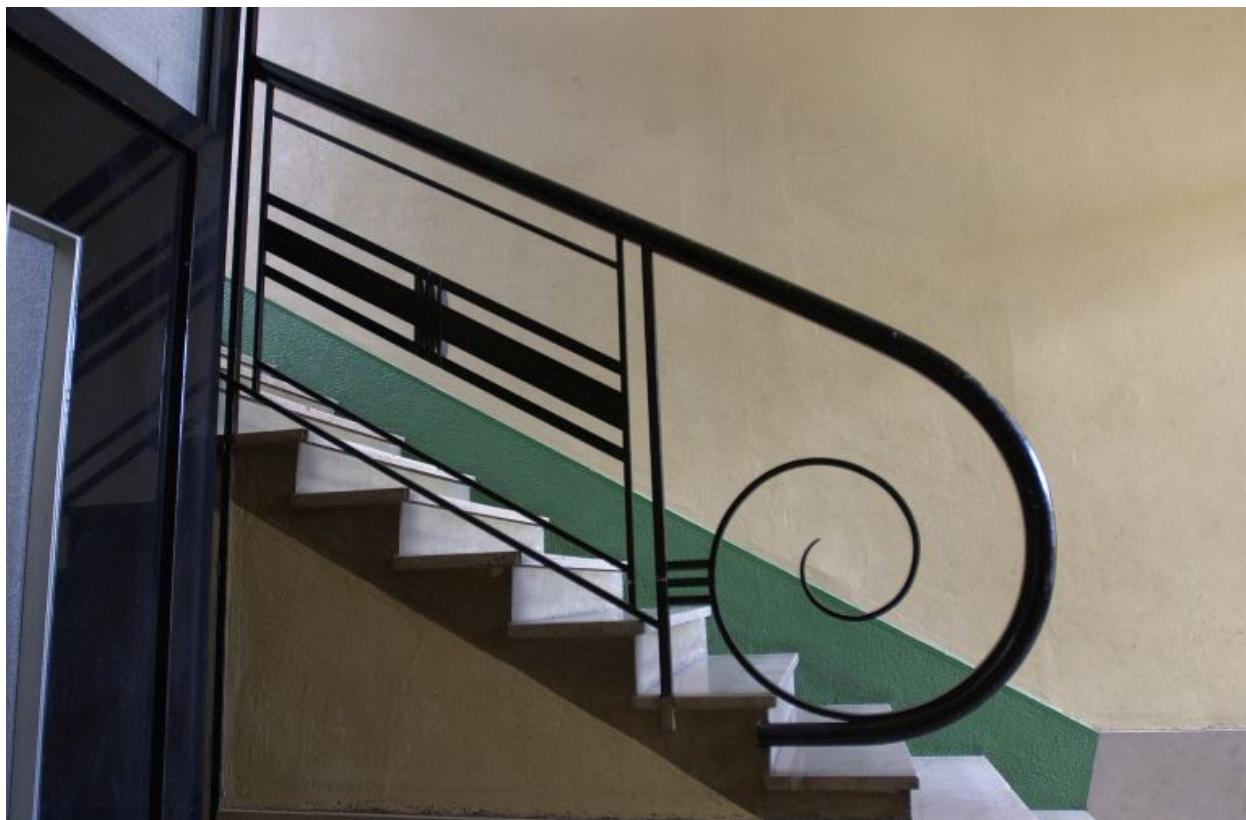
Détail de la rampe d'escalier, 21-23 rue Casimir-Perier
