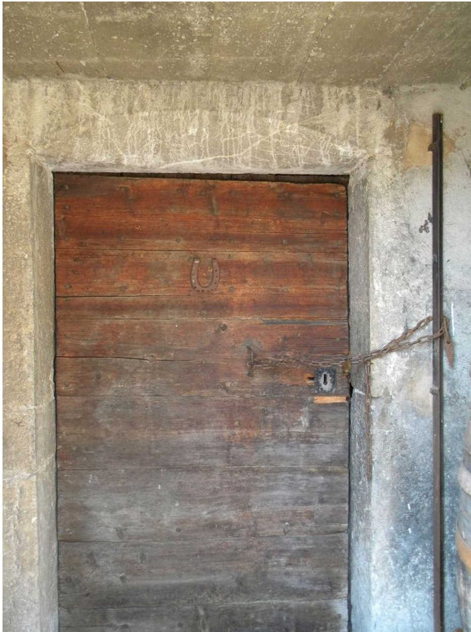
Vue de la porte de cave avec linteau délardé.
