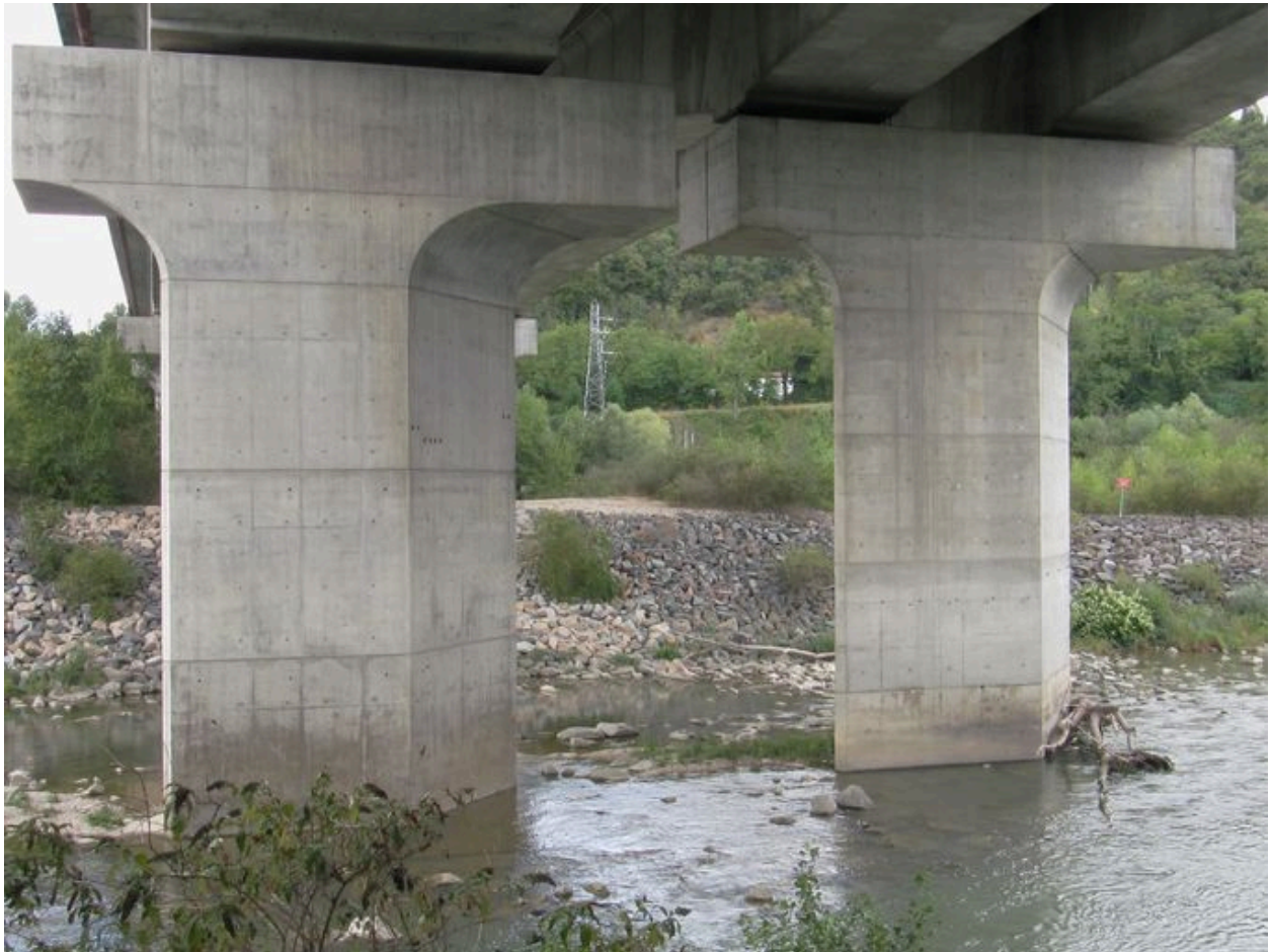
Vue de deux piles (depuis la rive gauche)
