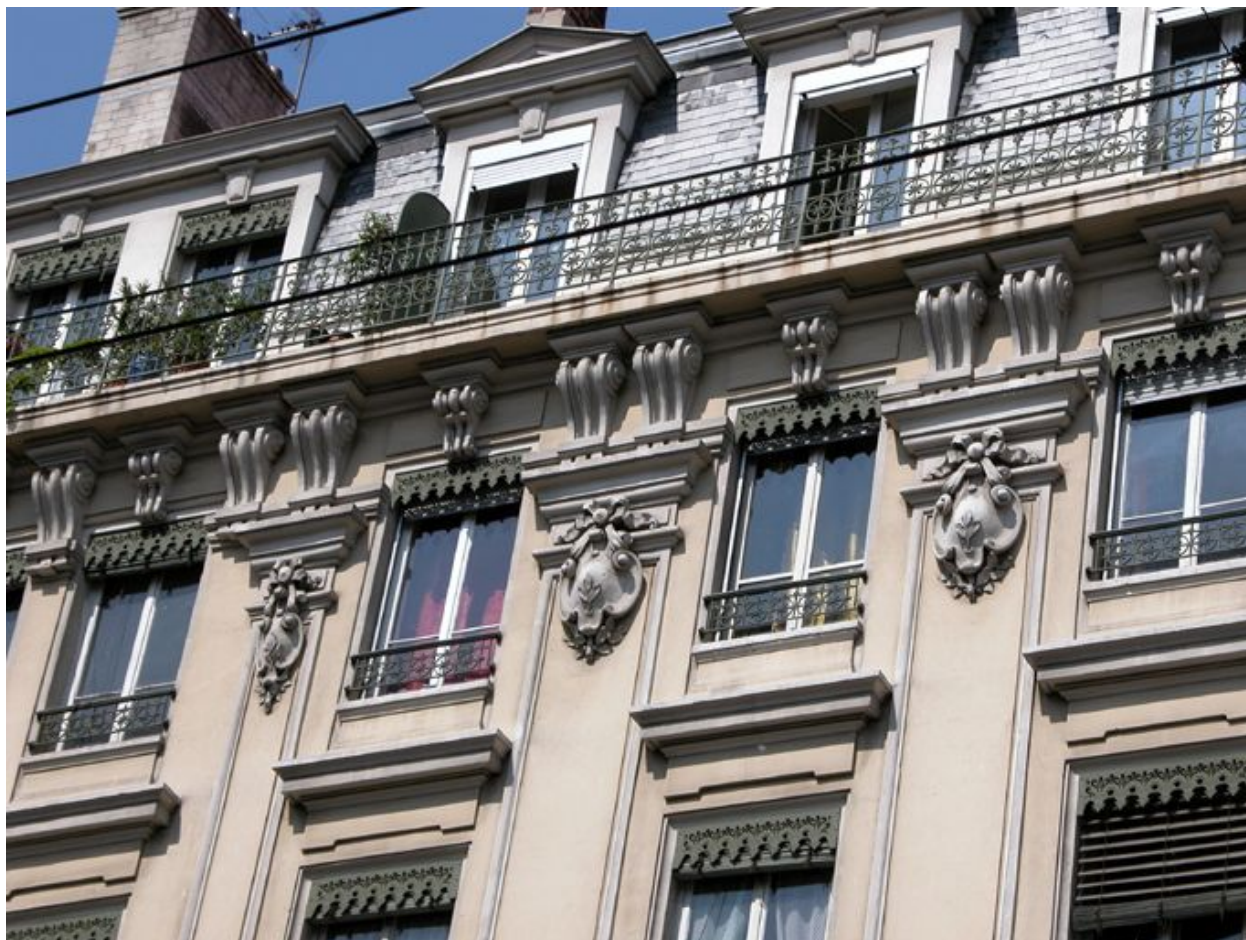
Balcon filant de l'étage de comble et décor sculpté de la façade
