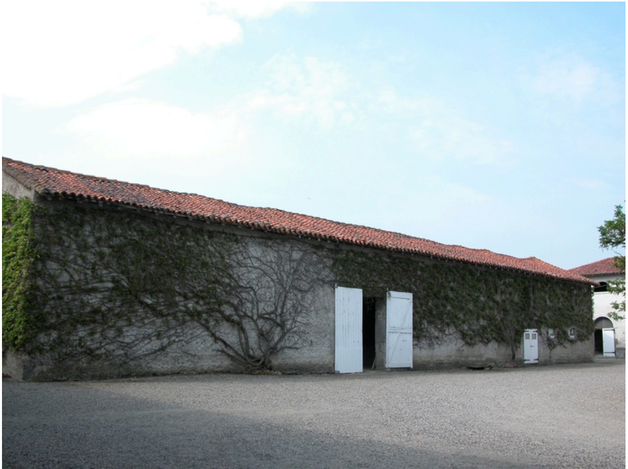
Vue de la grange-étable depuis la cour.
