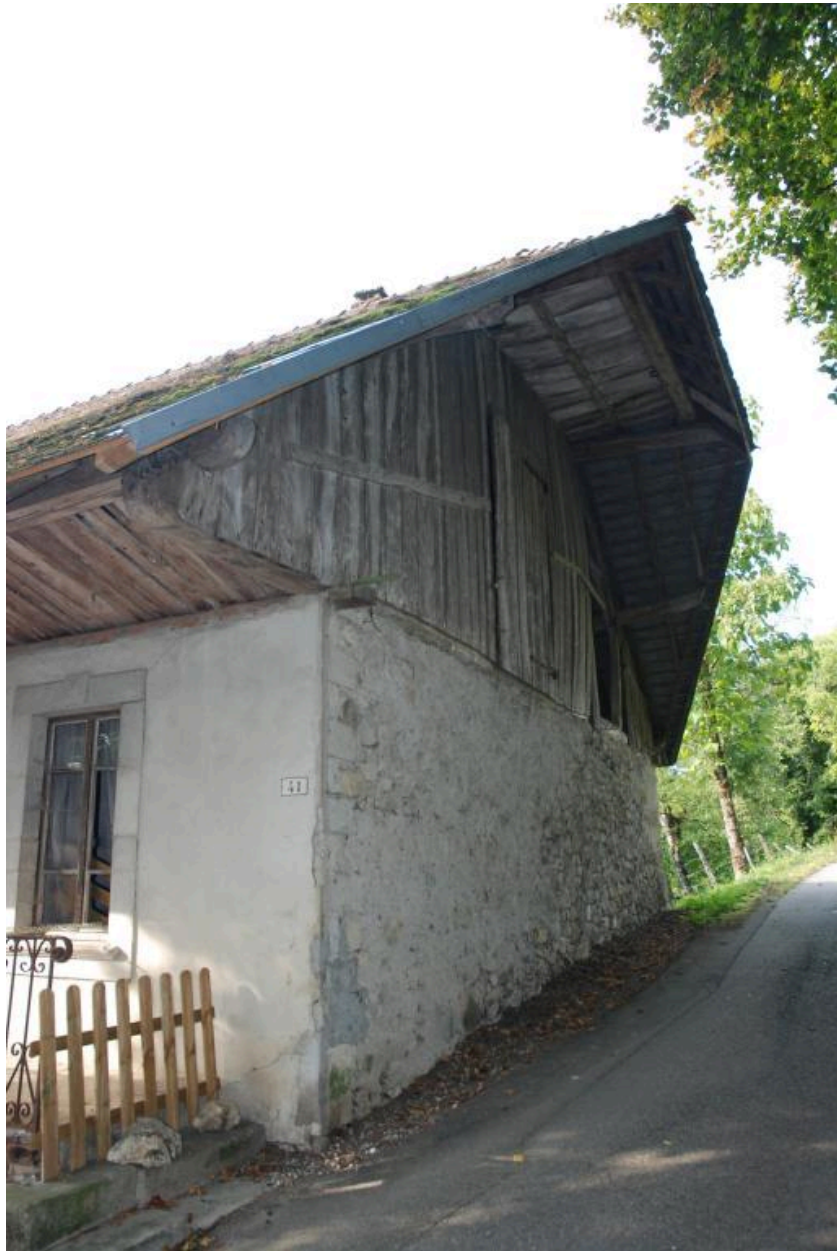
Vue d'ensemble du mur pignon est.
