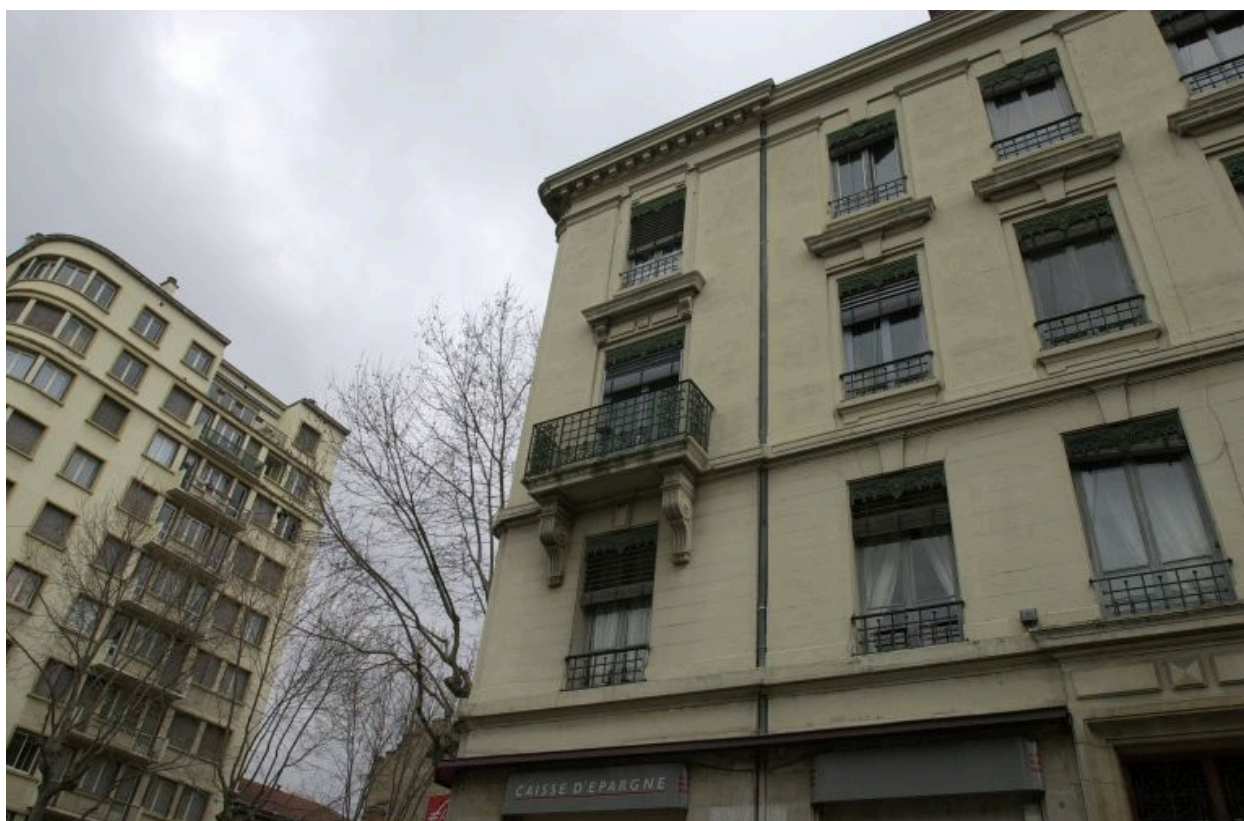
Détail des fenêtres, rue Marc-Antoine-Petit
