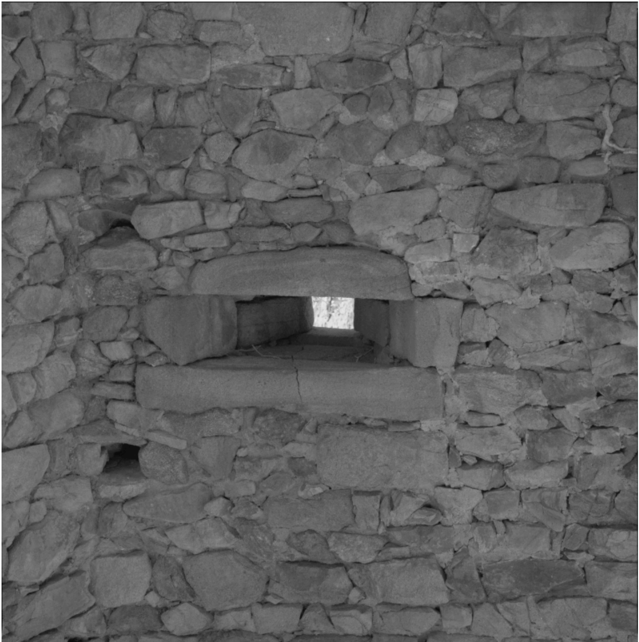
Ouvrage d'entrée, mur nord-est extérieur : détail de la canonnière, du nord-ouest.
