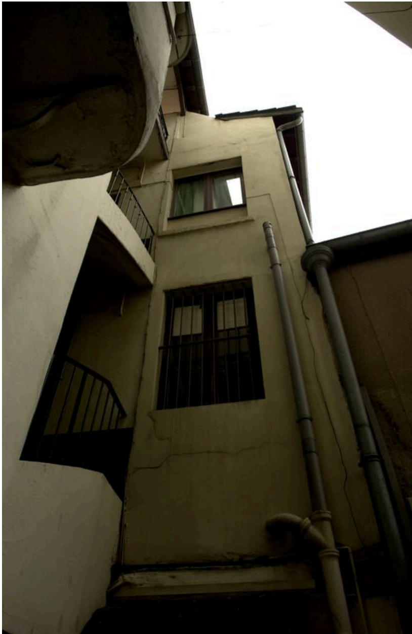
Corps de bâtiment sur rue : le corps de passage vers le 185
