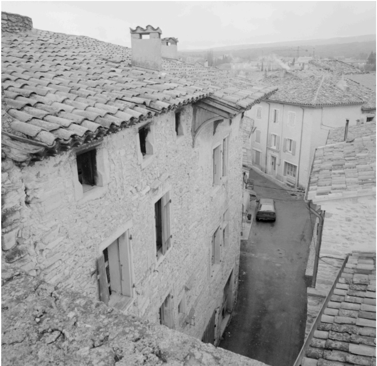
Façade sur rue, vue partielle, avec avant-toit sur aisseliers, prise depuis la terrasse de la lanterne.
