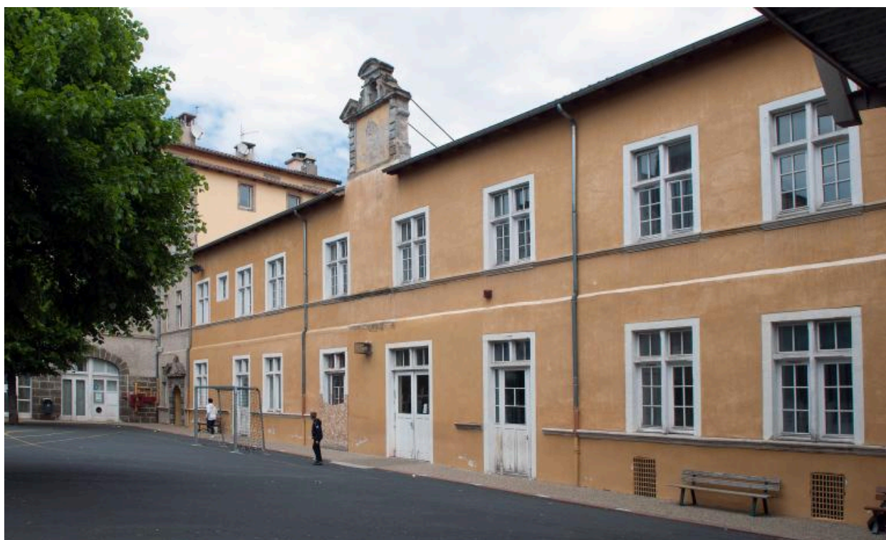
Bâtiment F : élévation sur cour 2, depuis le sud
