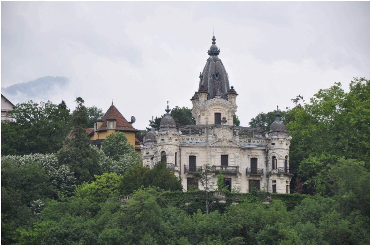
Vue générale prise de l'ouest
