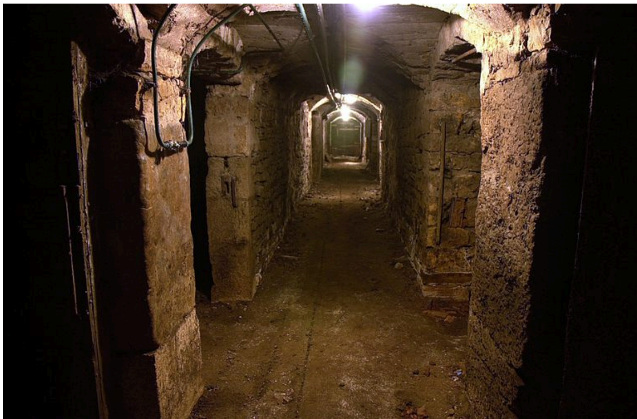
Caves sous l'immeuble 3 rue de Savoie : vue depuis le côté rue de Savoie
