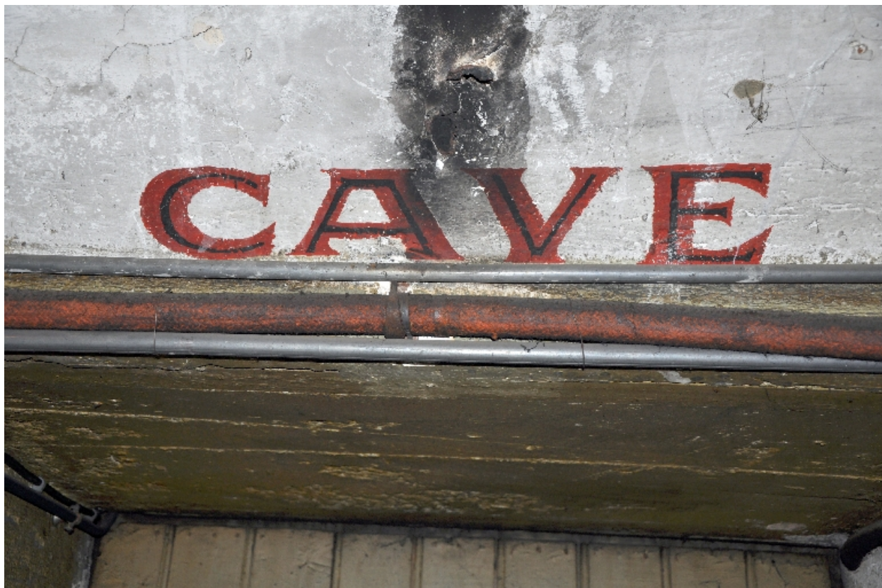
Sous-sol de l'aile N-W : inscription au-dessus de l'ancienne porte de la cave
