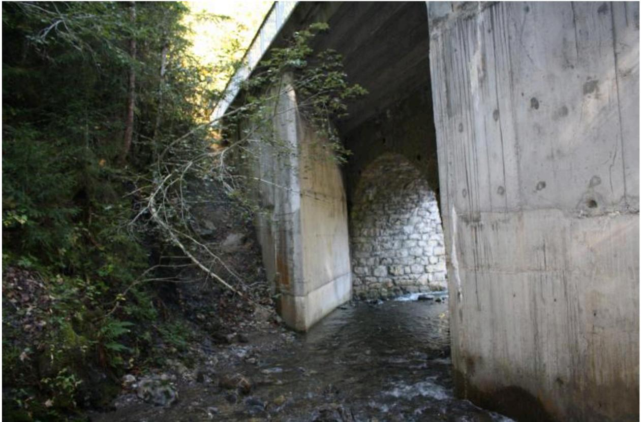
Pont de Dinn; vue amont; détail élargissement cullées en béton
