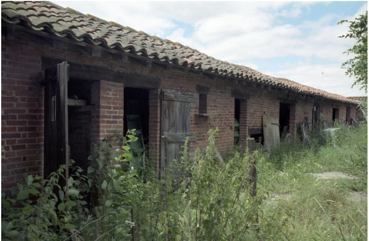
Vue d'ensemble des porcheries, depuis le sud-est.
