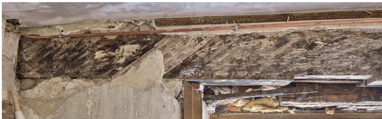
Rez-de-chaussée de la maison, salle à manger, détail des poutres en bois encadrant les baies de l'élévation sud.
