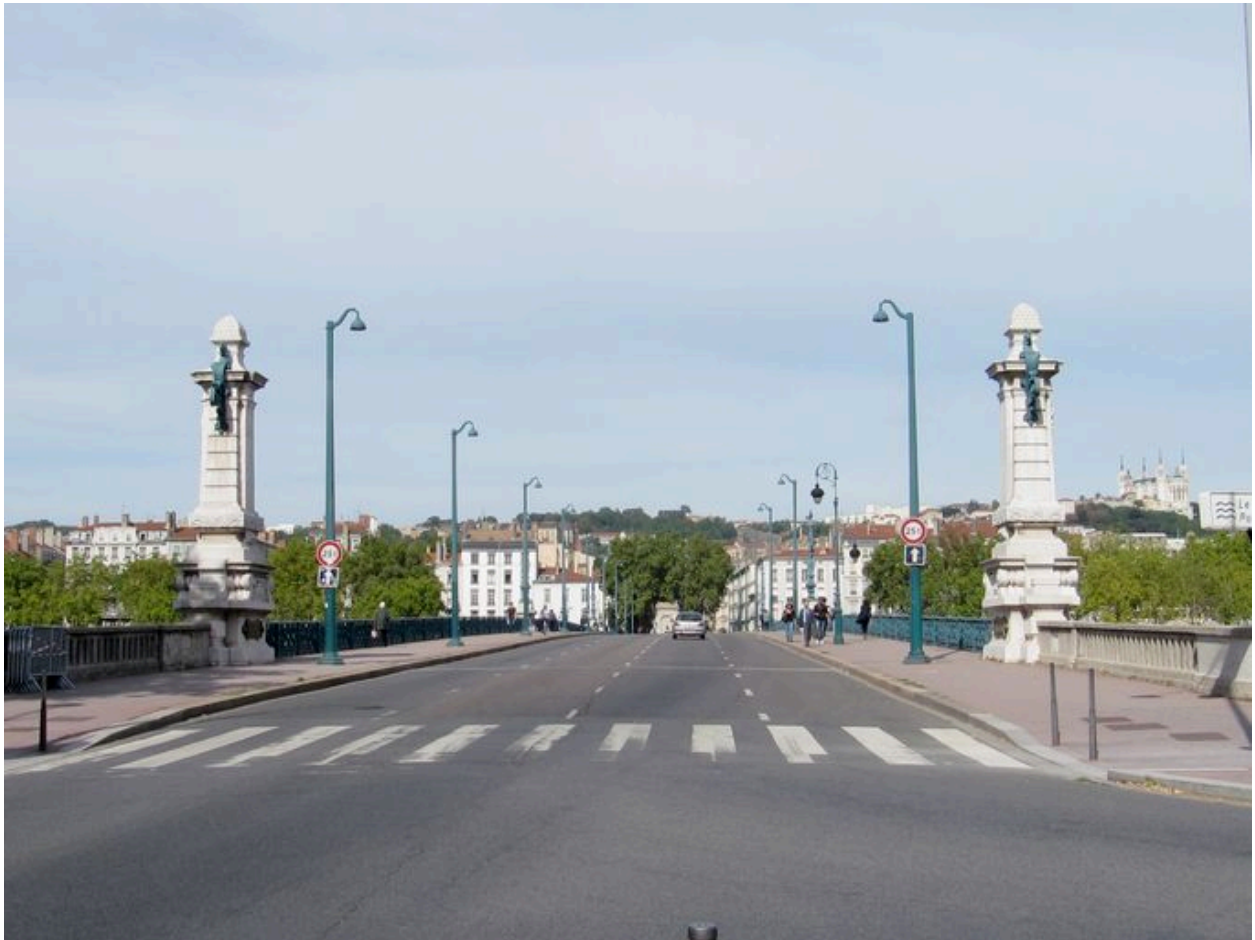
Vue générale, de dessus, chaussée (depuis la rive gauche)
