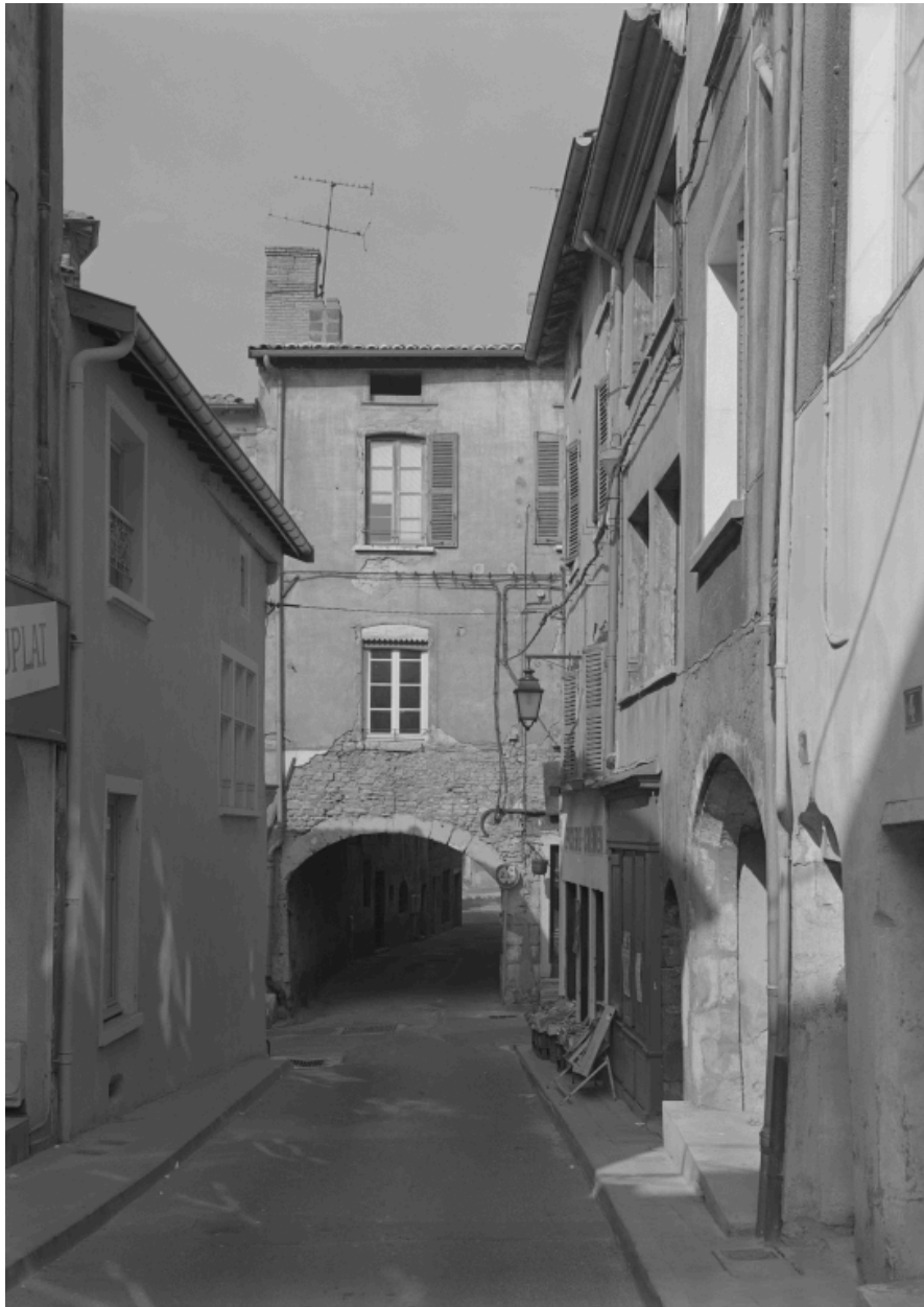
Passage couvert rue de l'Herberie, dit La Voûte, côté est.
