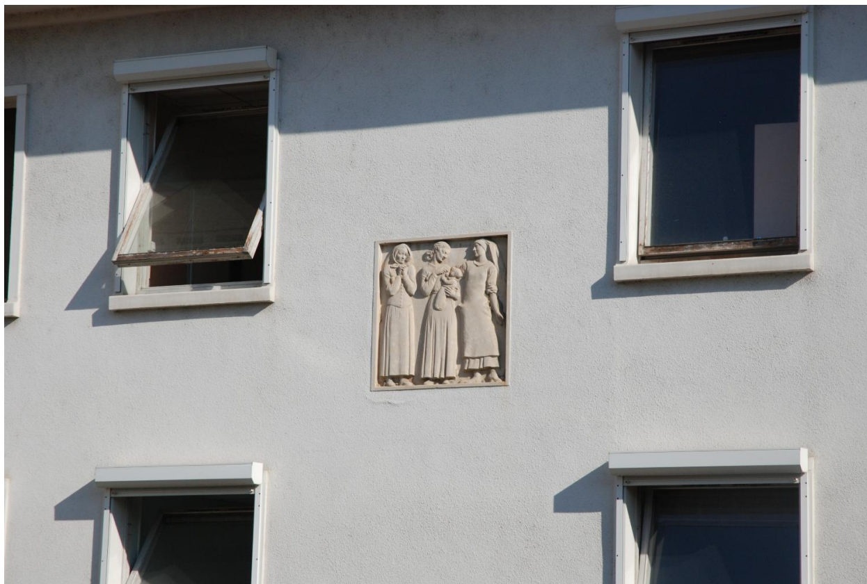
Bâtiment de la maternité, détail de l'élévation sud.
