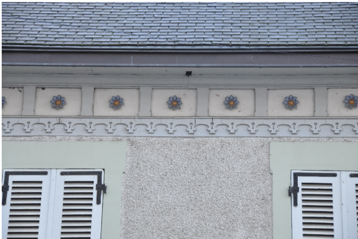
Détail de la frise extérieure
