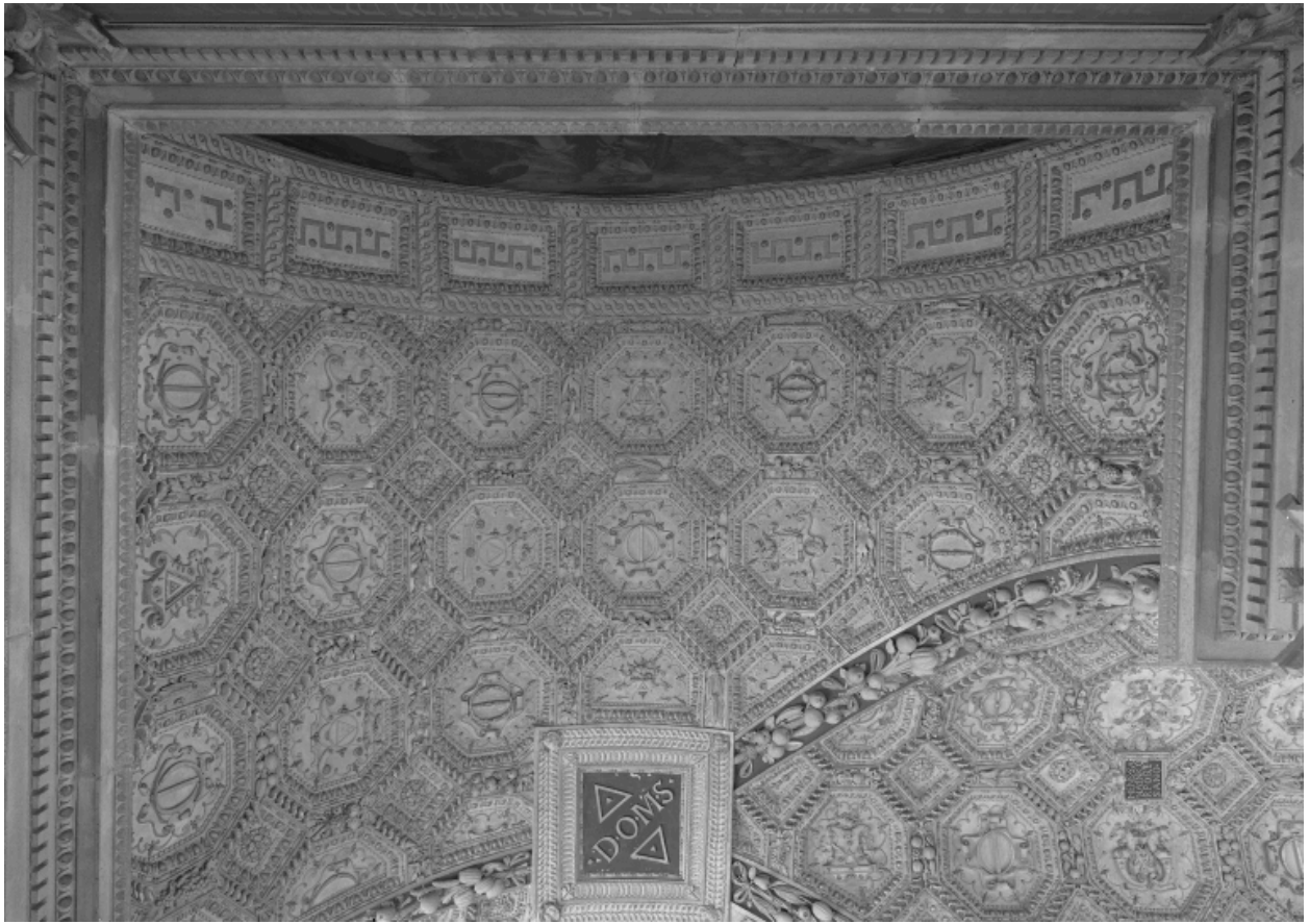
Vue générale du voûtain, côté entrée.
